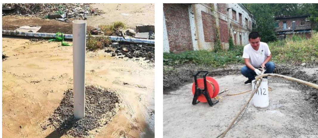
图 5.3-9 本场地所建地下水监测井
