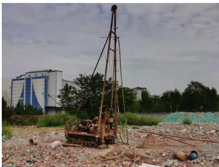
图 5.3-8 地下水井钻探设备
