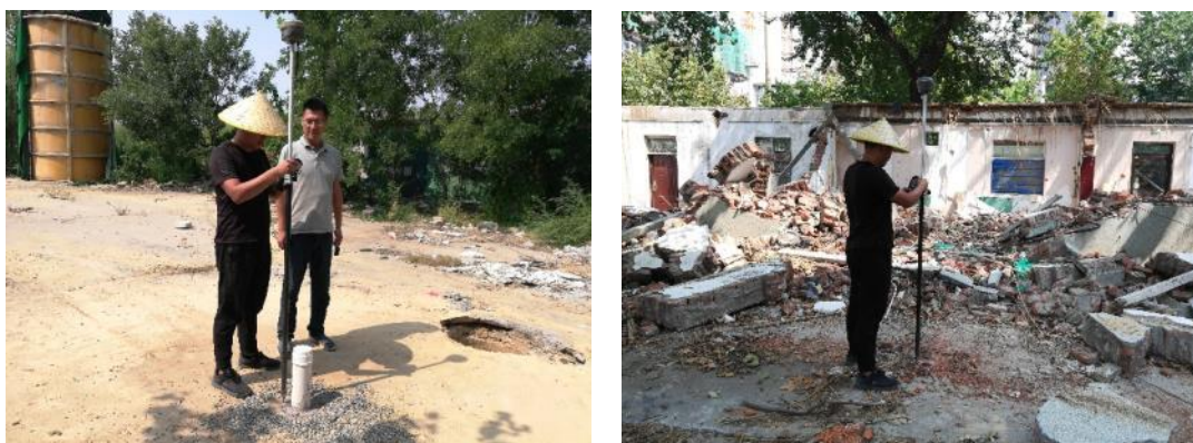
图 5.3-3 现场放点测绘工作
