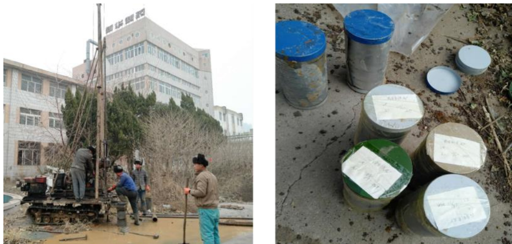
图 3.2-1 地质勘察工作情景和土工试验样品
